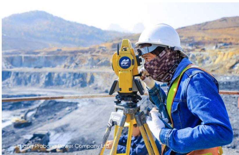
土建工程启动前的河岸测量工作
