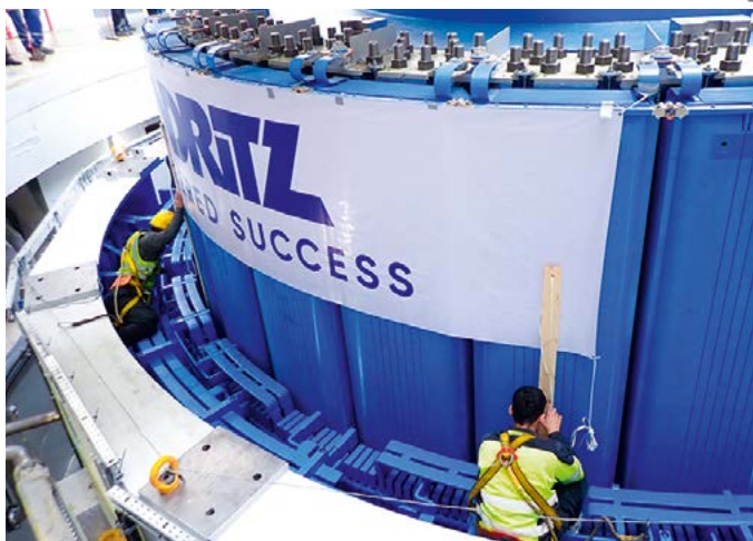
A-1机组电动发电机转子吊入机坑
