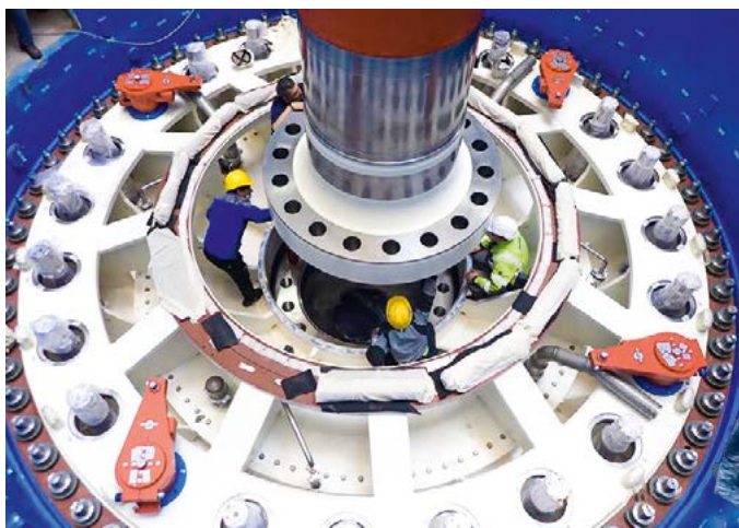
安装A-1机组水轮机轴和导向装置
