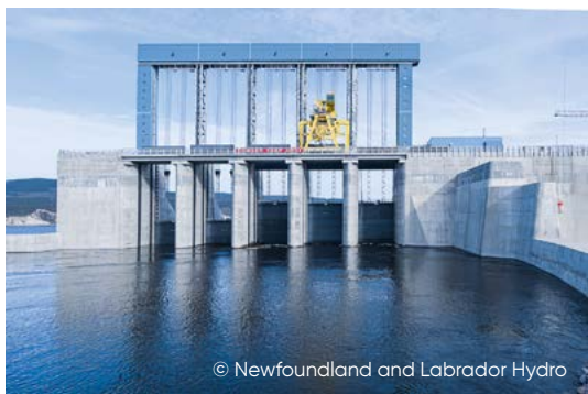
带拦污栅的进水口闸门
