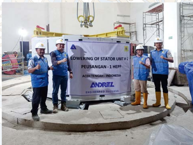
Peusangan 1水电站1号机组定子吊入基坑
