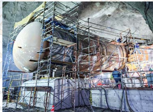
2023年年初, 完成Asahan 3水电站的钢管压力测试。
