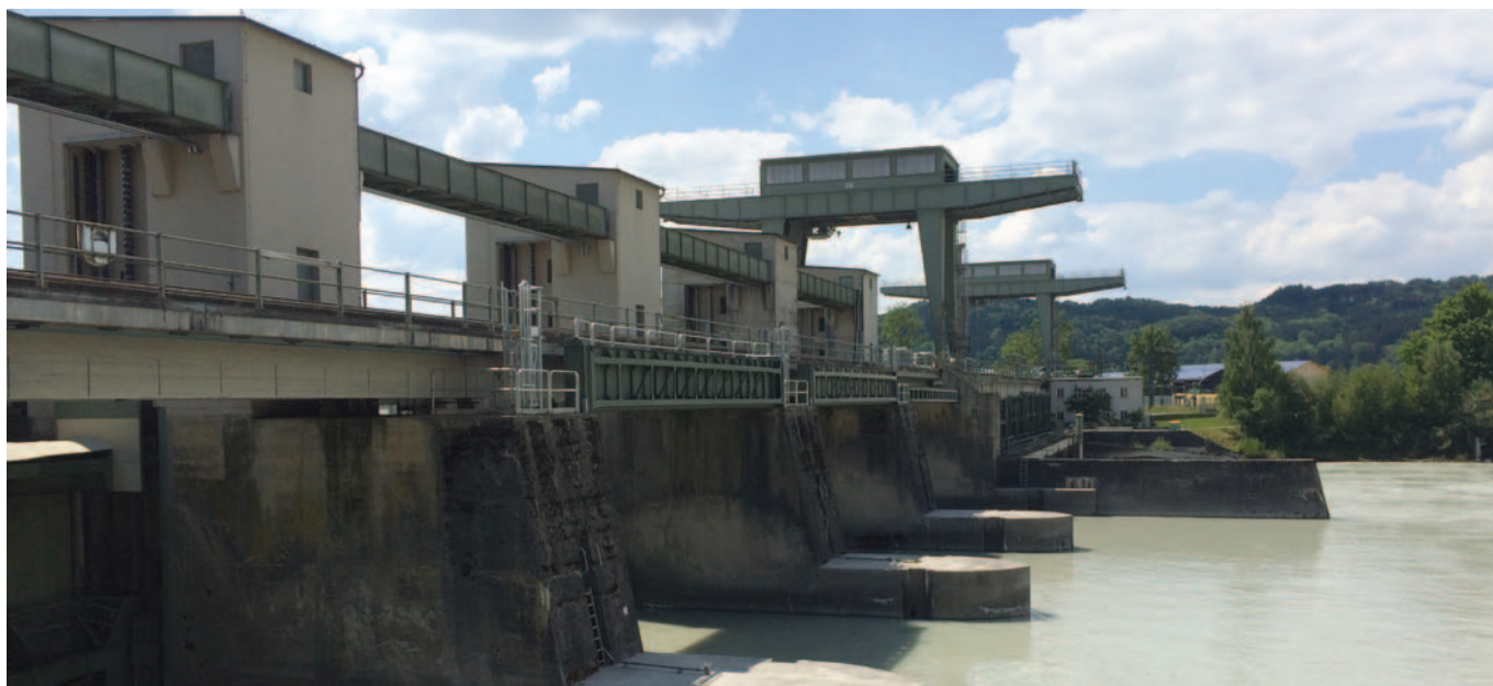
▲ La centrale hydroélectrique de Gars en Allemagne
