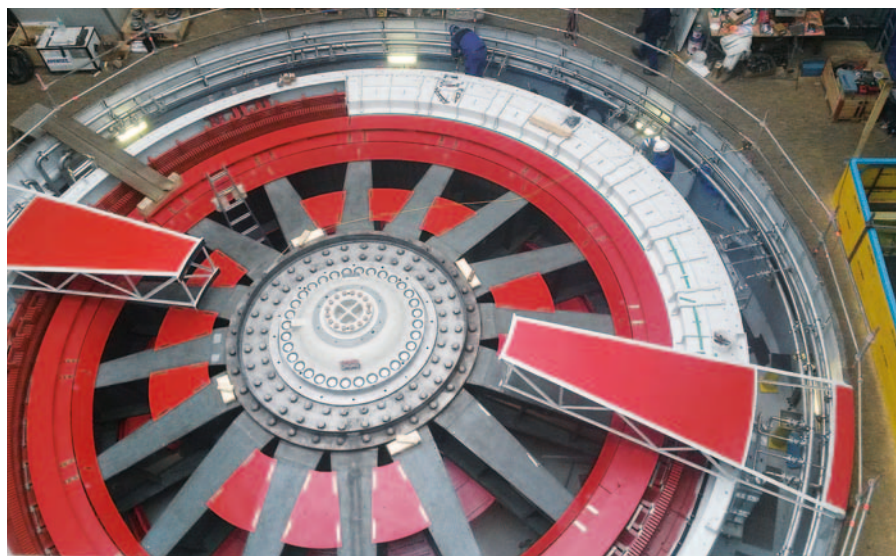
▲ Installation des capots de l'alternateur
