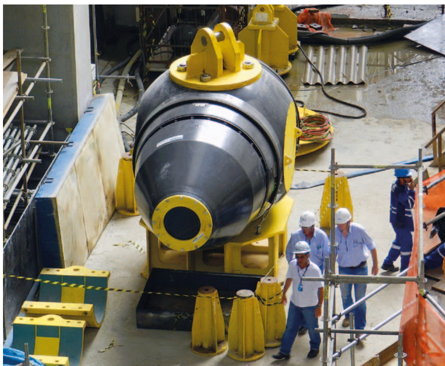
▼ Installation d'une roue Kaplan dans la CHE de Pimental
