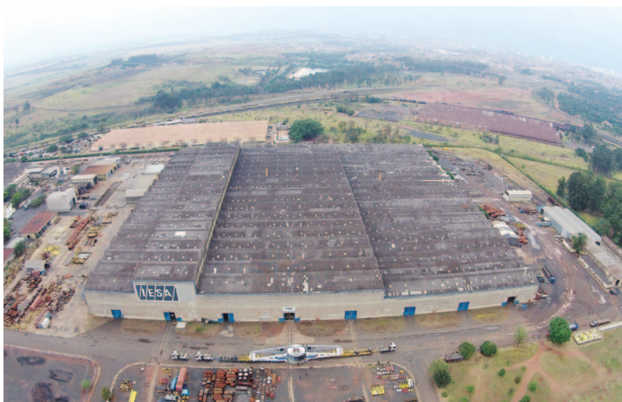
▲ Le site d'ISEA à Araraquara et la roue de la CHE de Belo Monte durant le transport
