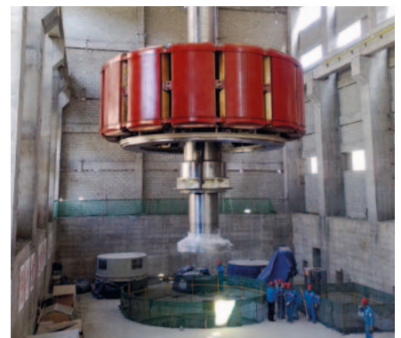
▲ Levage du rotor
