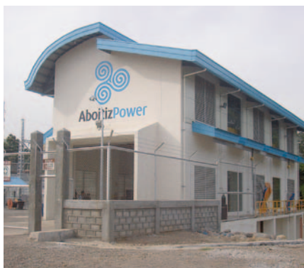
Bâtiment de la centrale hydroélectrique de Tudaya 2
