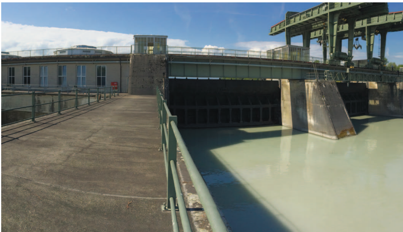
▲ La centrale hydroélectrique de Rosenheim
