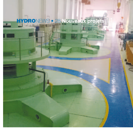
▲ Les unités n°1 à 4 avant la réhabilitation
